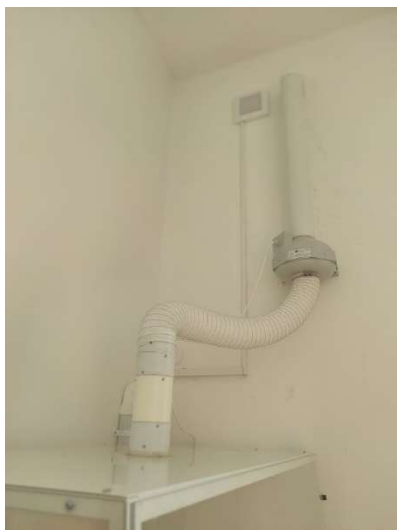
Instalace ventilátoru – kabinet chemie
