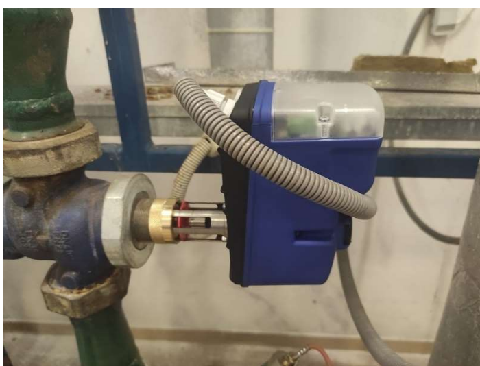
Výměna servopohonu – kotelna
