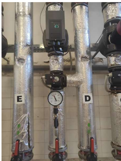
Výměna čerpadla – kotelna
